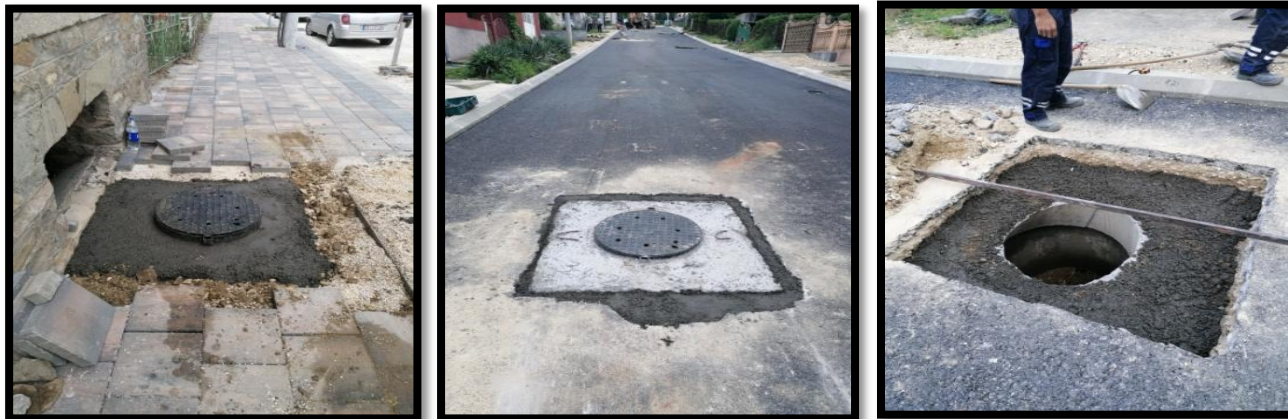
Фотографије замене и нивелисање шахт поклопаца
