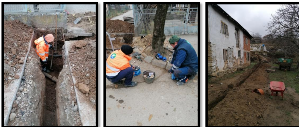
Фотографије реконструкције водоводног прикључка на КП.6018 и КП.5949 у улици Косовској
