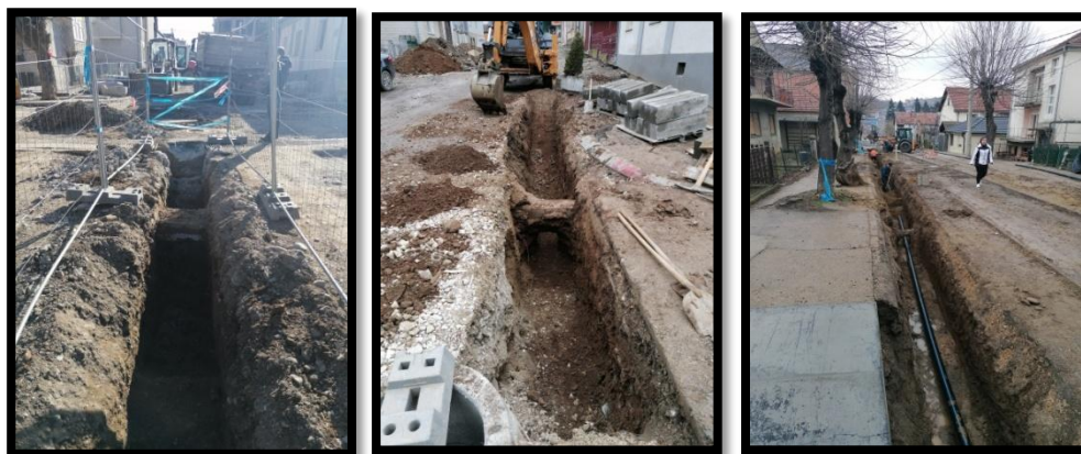
Фотографије реконструкција канализационе мреже у улици Карађорђевој
