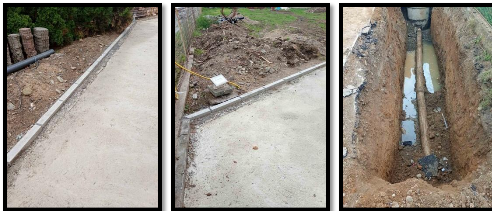
Фотографије изградње дренажне галерије на КП.4988 СПЦ Црква Свете Троице
