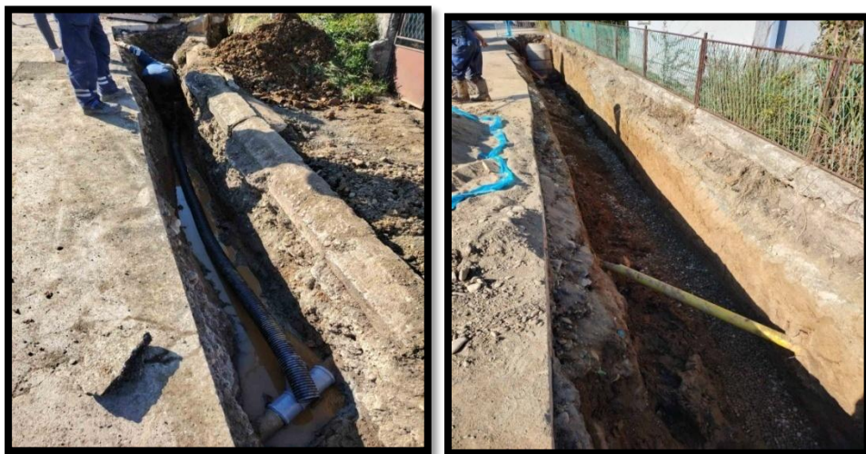
Фотографије реконструкције канализационе мреже и израда потпорног зида у улици Његошевој број 14, 14/1 и 14/2
