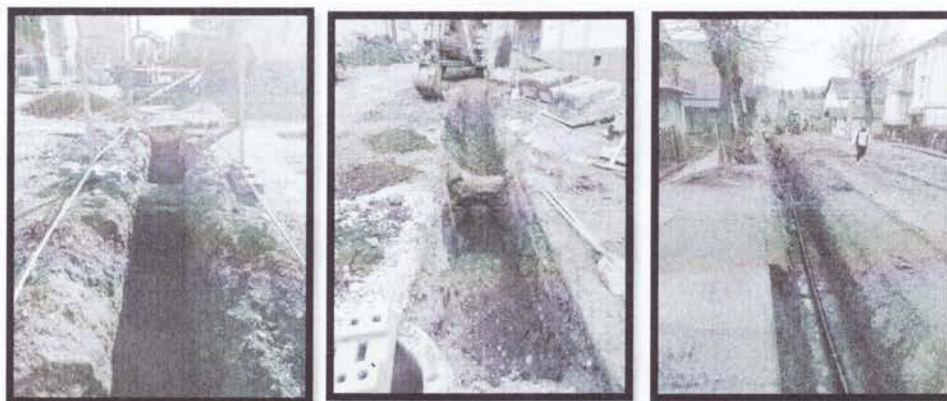
Фотографије реконструкција канализационе мреже у улици Карађорђевој
