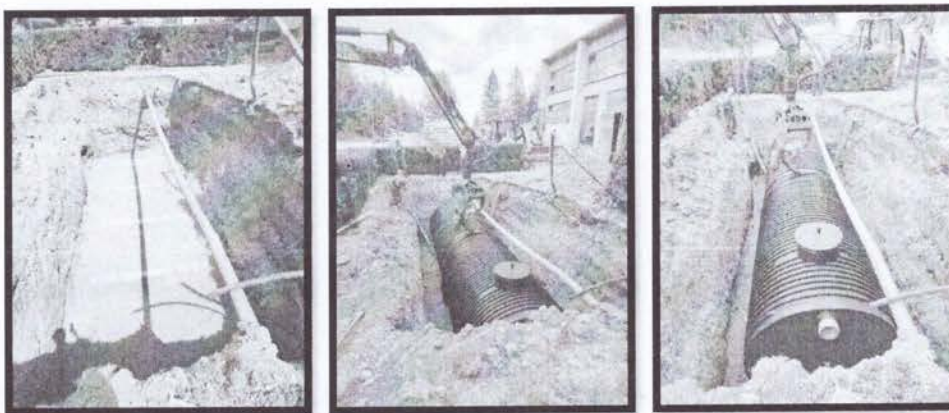
Фотографије уградње цистерне за отпадну воду „Симпо Шик“
