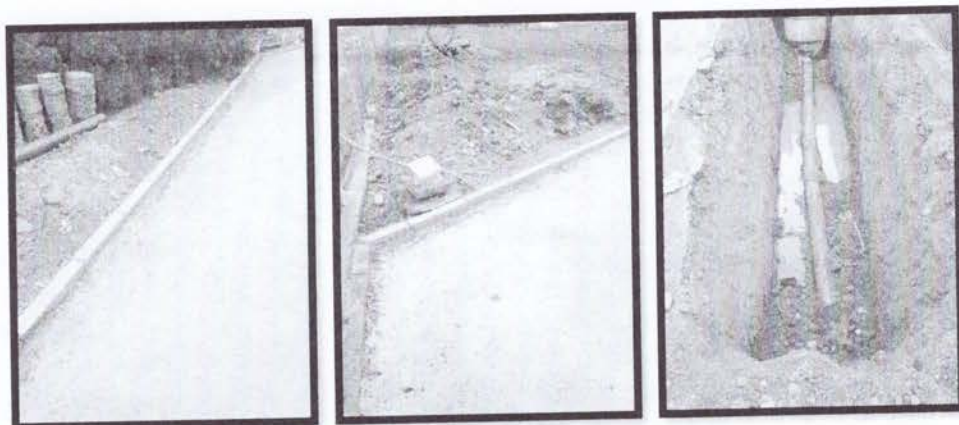
Фотографије изградње дренажне галерије на КП.4988 СПЦ Црква Свете Троице
