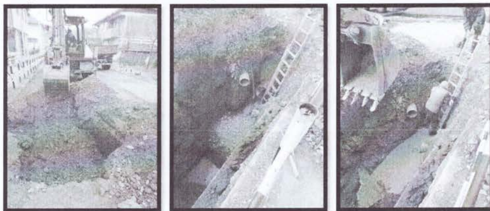
Фотографије реконструкције фекалне канализације у улици Дринке Павловић
