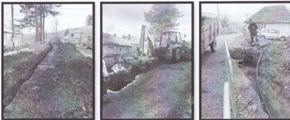
Фотографије реконструкције градског резервоара „Боровњак“
