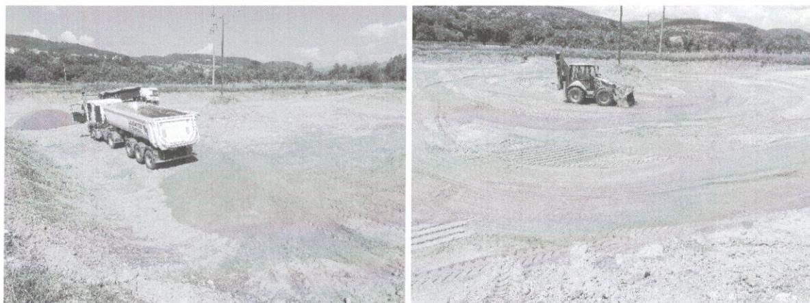
Чишћење инфильтрационог базена бр.3, замењено  $150\text{m}^3$  песка
