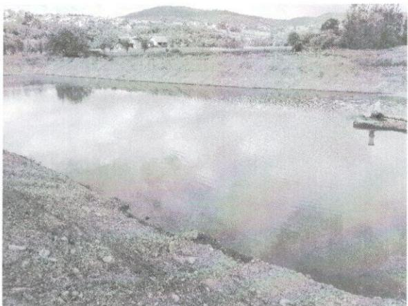
Чишћење инфильтрационог базена бр.2, замењено 300 м<sup>3</sup> песка
